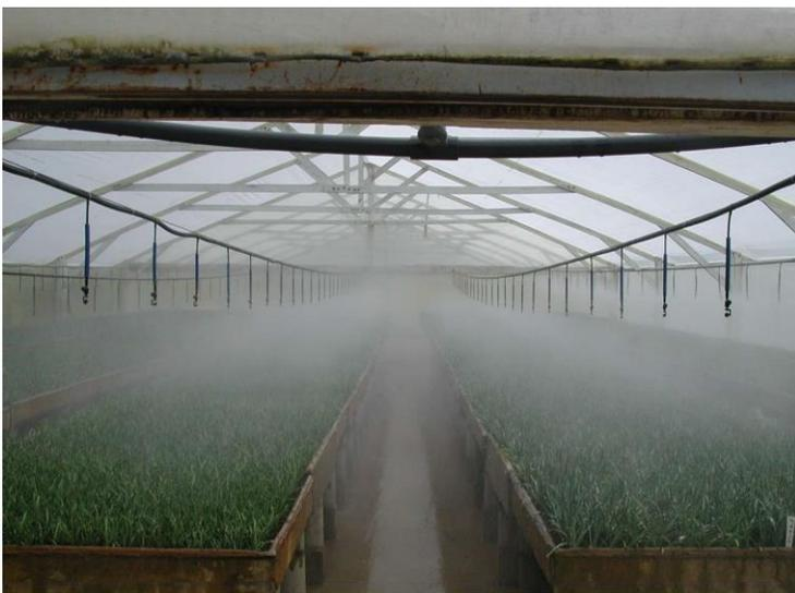
B) Foggers de 7 litros/hora por salida con válvula antigoteo.
